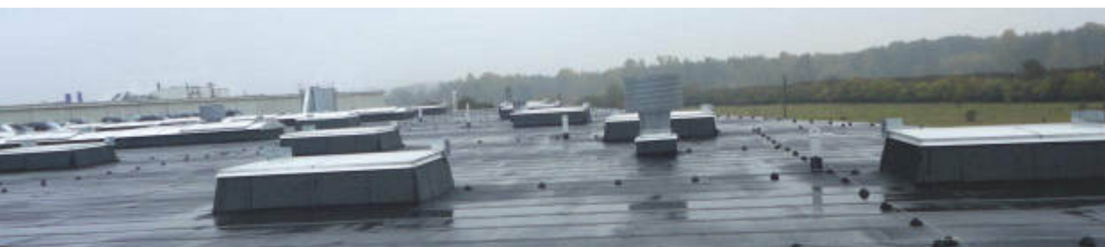
Stare pokrycie papowe, należy zagruntować przed przystąpieniem do dalszych prac renowacyjnych.
