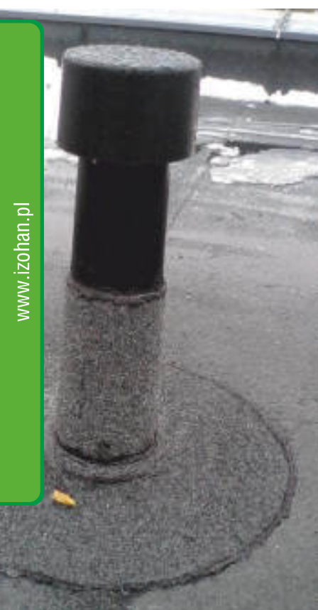
Kominek wentylacyjny - prawidłowy sposób obróbki.
