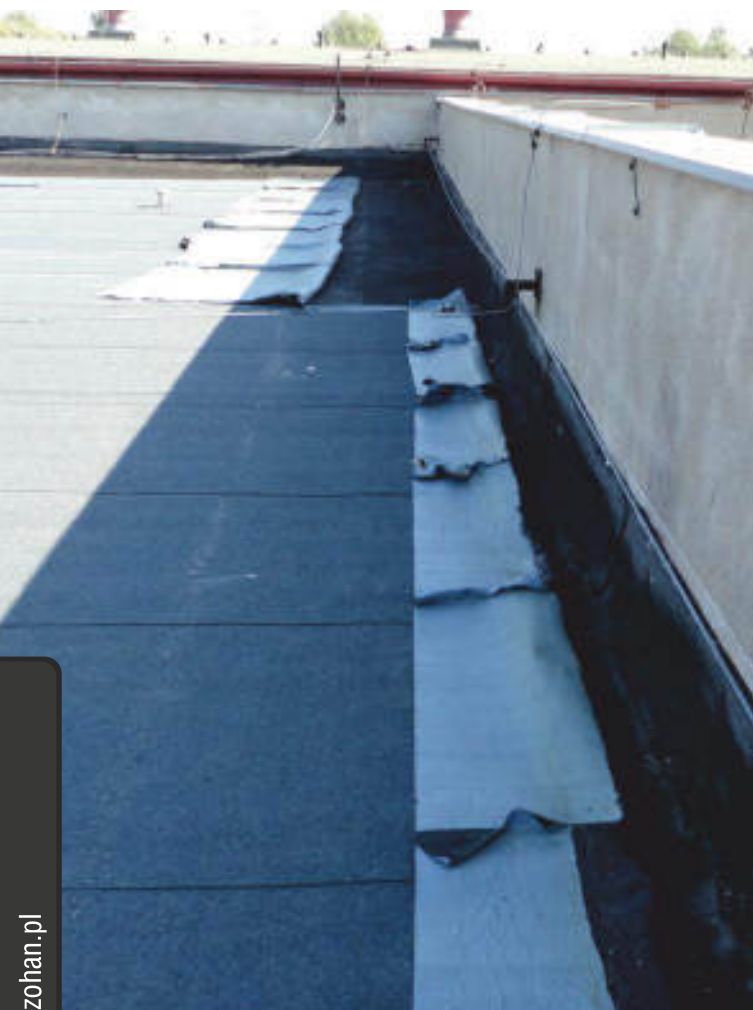
Papa samoprzylepna IZOLMAT TOP SP ułożona na powierzchni poziomej, przed jej wyniesieniem na element pionowy.
