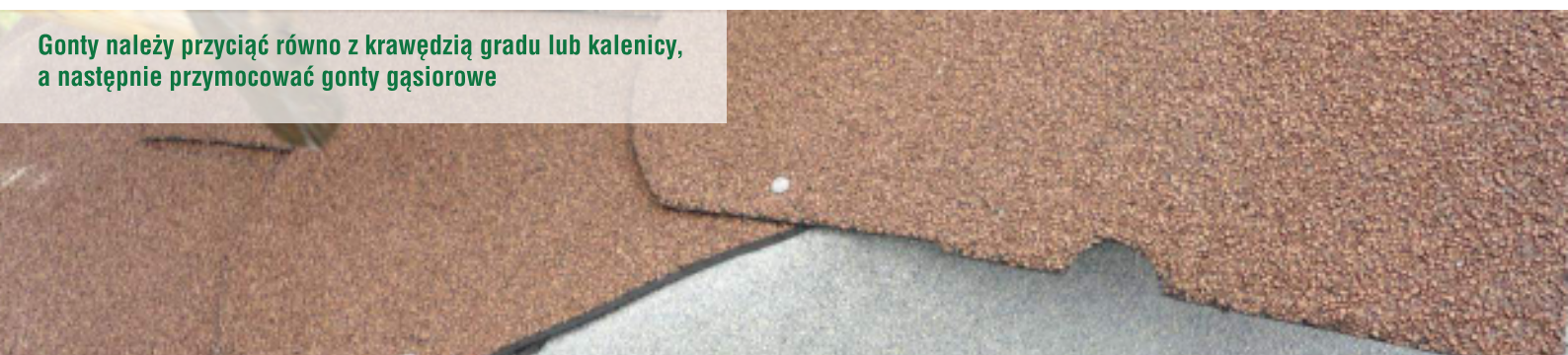
Obróbka kalenicy gontami o kształcie prostokątnym.
