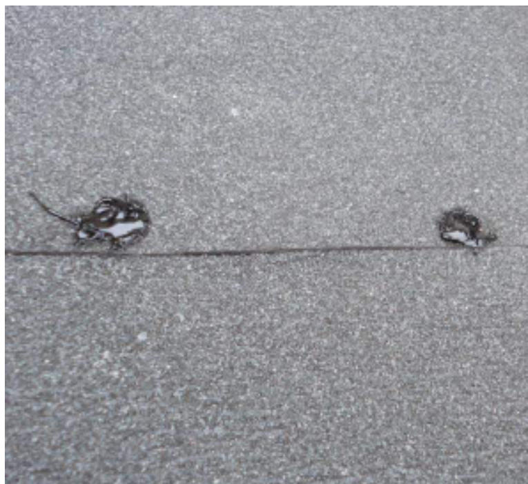
Uszczelnienie gwoździ papowych na zakładzie membrany.
