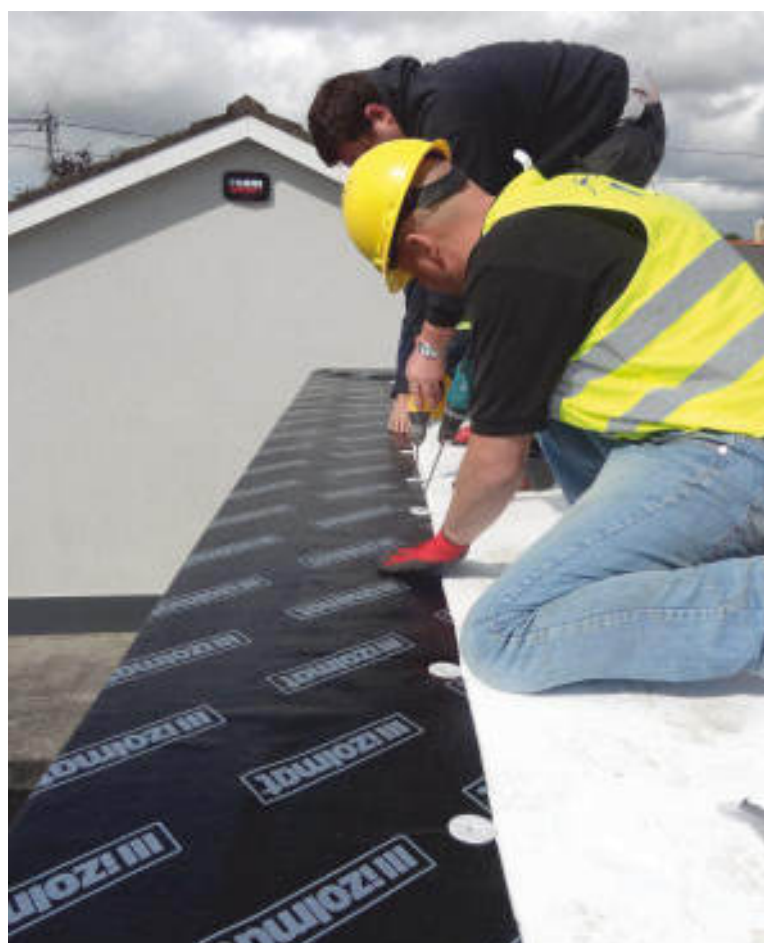
Mocowanie termoizolacji.
