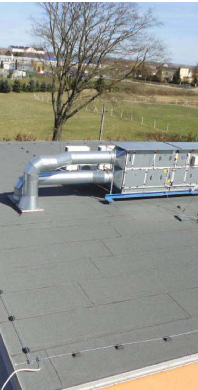
Prawidłowo wykonana izolacja dachu na blasze fałdowej na warstwie wełny mineralnej. Pierwsza warstwa papy podkładowej mocowana mechanicznie.
