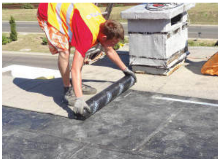
Rozwinięta połowa rolki zabezpiecza przed przesuwaniem się papy podczas zgrzewania.
