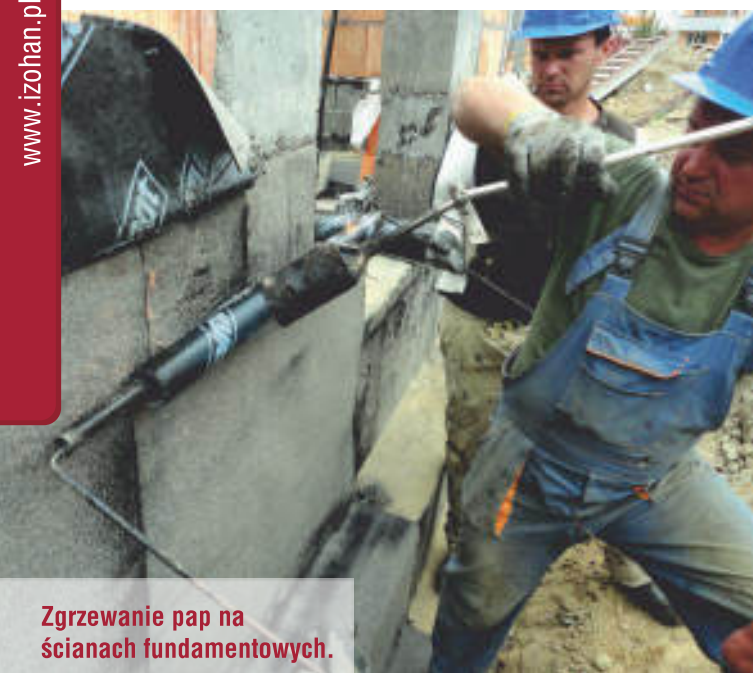
Szczelne wykonanie izolacji na ławie i ścianach fundamentowych przy użyciu papy zgrzewalnej.
