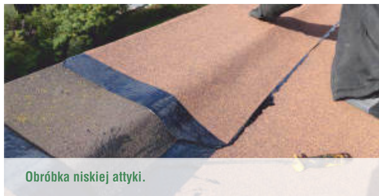
Dach oźebrowany pokryty papą zgrzewalną.
