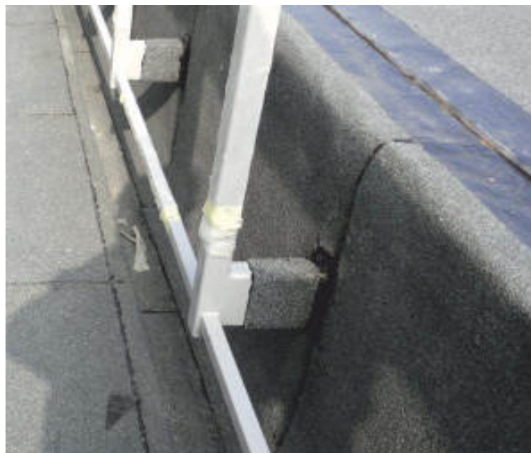
Mocowanie balustrady tarasu do boku murku.
