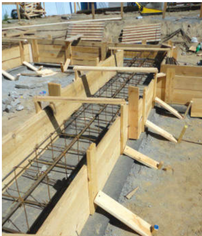
Deskowanie pod ławę fundamentową.
