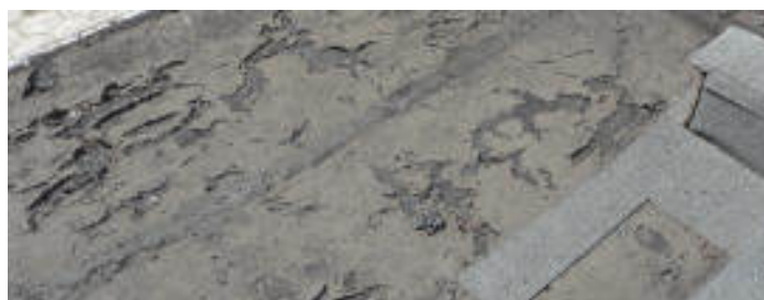
Przed położeniem nowej papy należy usunąć luźne części z podłoża.
