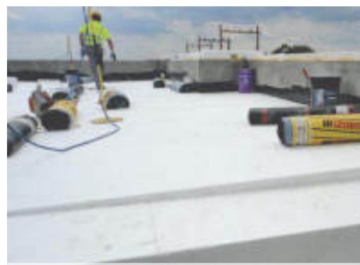
Płyty spadkowe klejone na właściwej warstwie izolacji.
