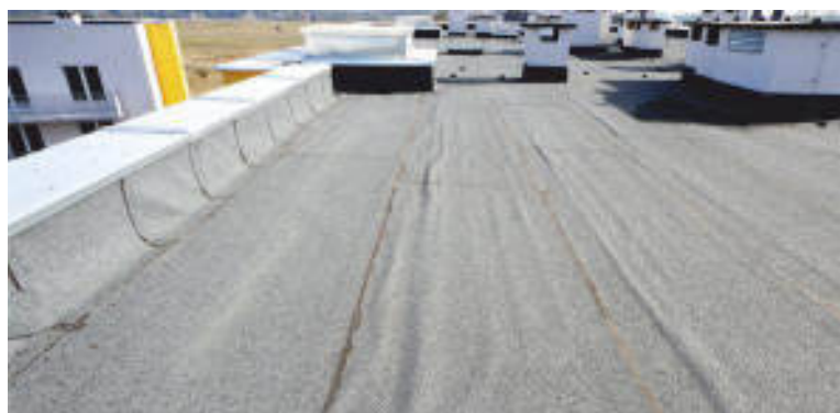
Montaż papy na podłożu drewnianym o dużej wilgotności. Nastąpiły przesunięcia na papie, a przez to jej sfałdowanie.
