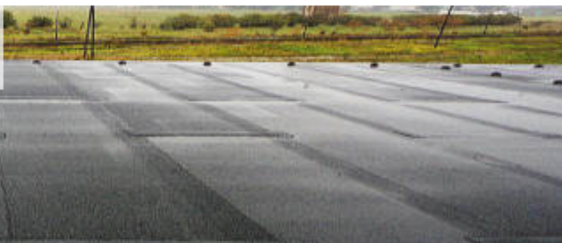
Montaż papy na podłożu drewnianym o dużej wilgotności. Nastąpiły przesunięcia na papie, a przez to jej sfałdowanie.
