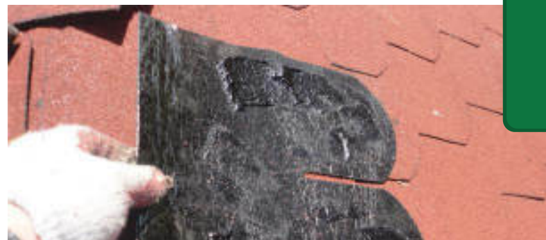
Prawidłowe podklejenie podwójnego elementu na obróbce kalenicy.
