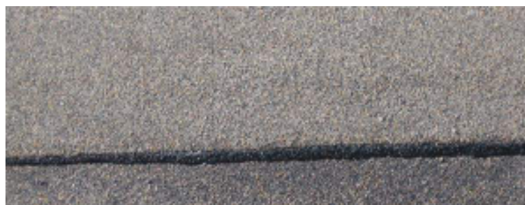
Wytop asfaltu przy zastosowaniu papy zgrzewalnej na paroizolacji jest również wymagany.
