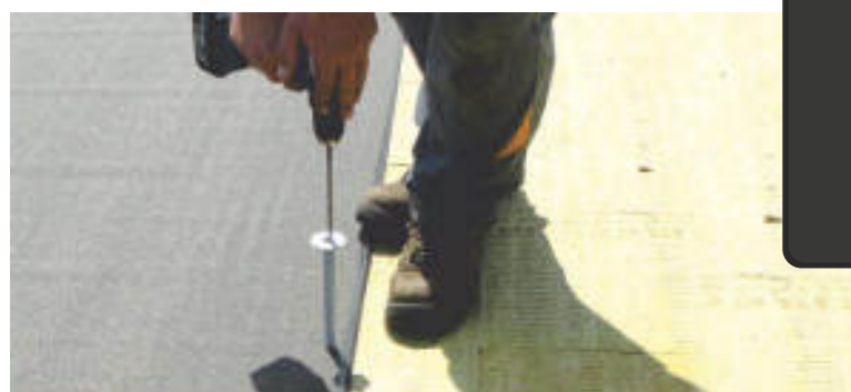
Do mocowania mechanicznego najbardziej zalecane są łączniki teleskopowe.
