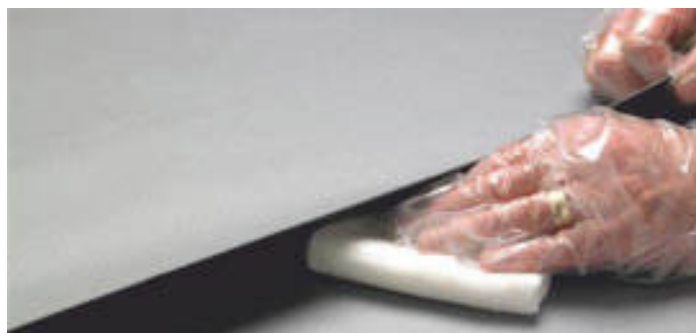
Czyszczenie zakładów membrany przed zgrzewaniem.
