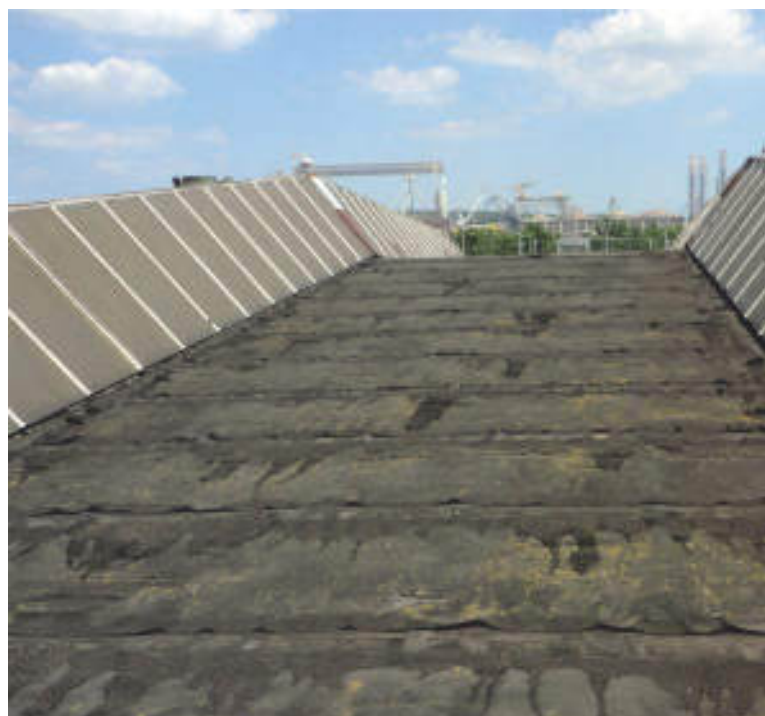
Zniszczona wierzchnia strona starego pokrycia papowego. Należy je usunąć przed aplikacją nowej warstwy papy.
