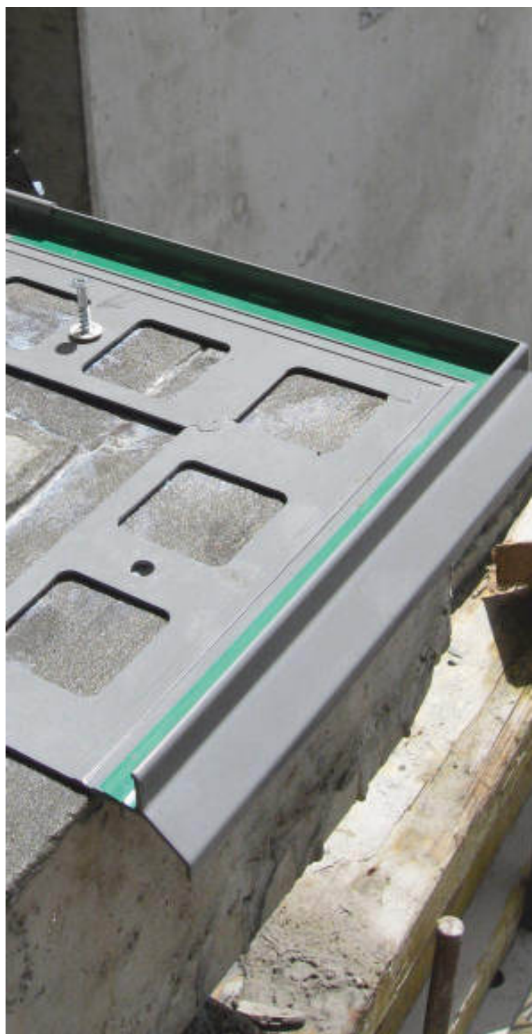
Profil krawędziowy zabezpieczający krawędź balkonu.
