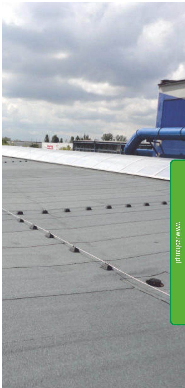
Dach pokryty membraną PVC.
