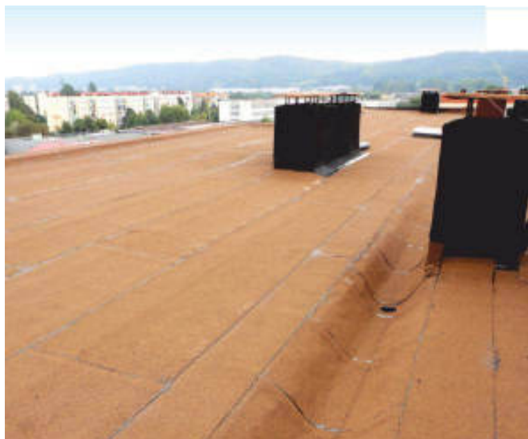
Prawidłowo wykonane koryto zlewowe.
