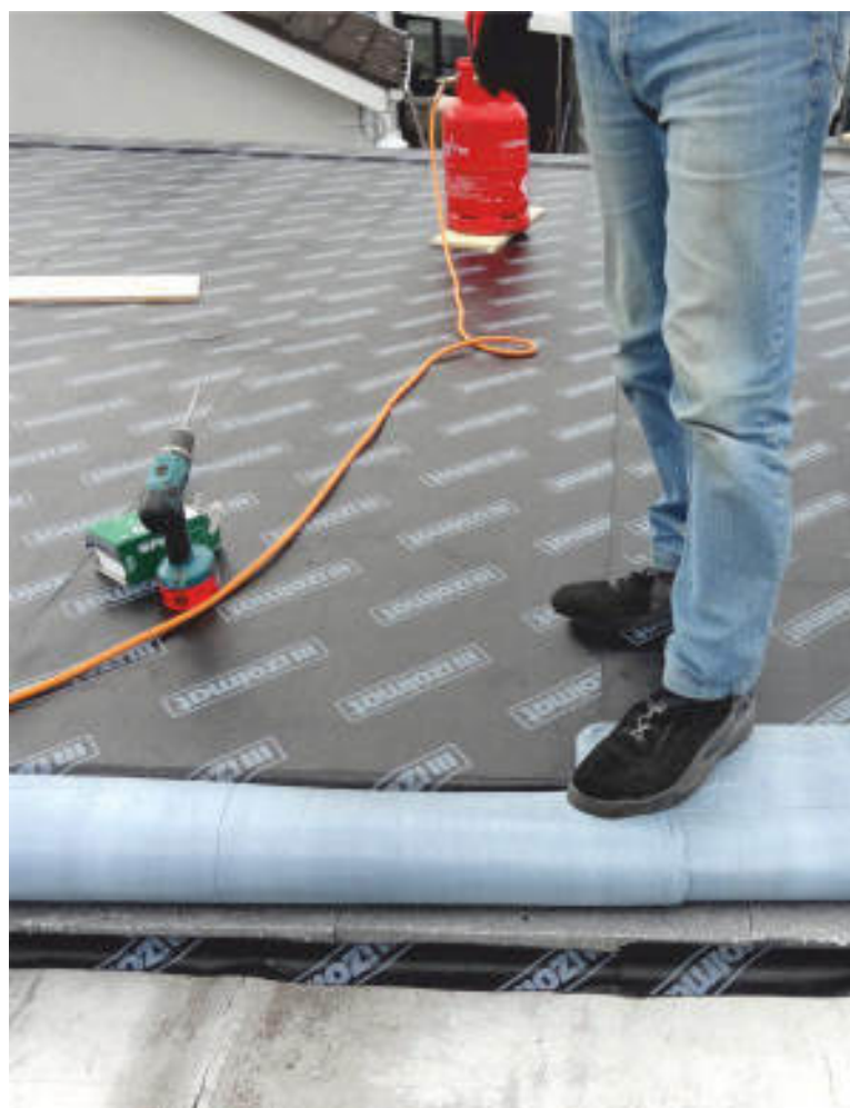
Zabezpieczenie krawędzi papy samoprzylepnej mocowanej na warstwie termoizolacji przed penetracją wody pod pokrycie w trakcie przerwy roboczej.
