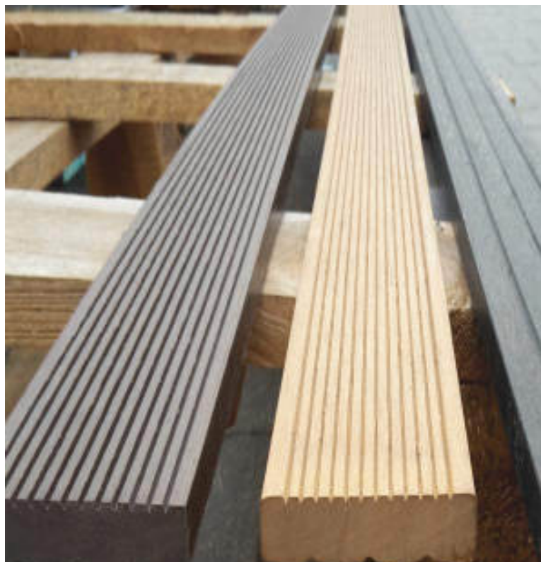
Deski drewniane tarasowe w różnych kolorach z różnorodnym profilowaniem z wierzchu i od spodu deski.
