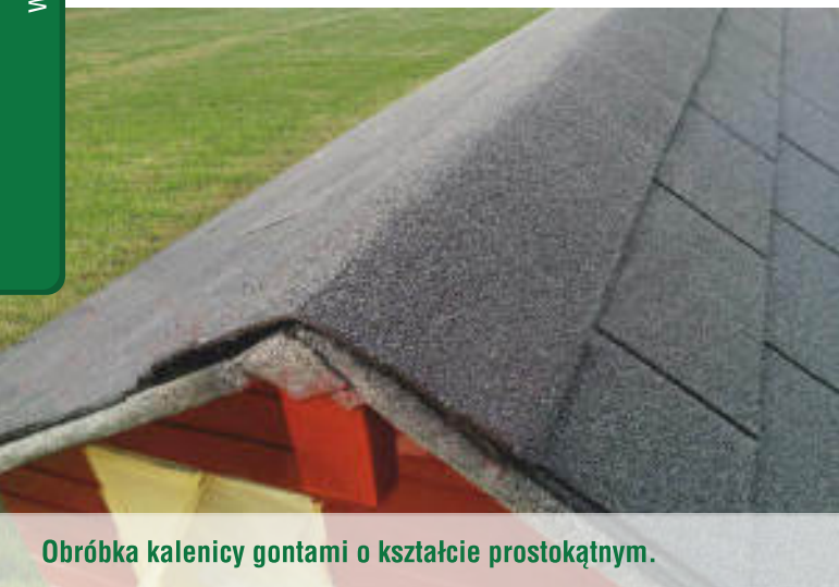
Kalenica na dachu pokrytym gontami.
