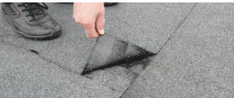
Nieprawidłowo wykonany zakład poprzeczny. Zakład nie został odpowiednio zgrzany i był zbyt wąski, brak wtopienia posypki na zakładzie na papie spodniej.
