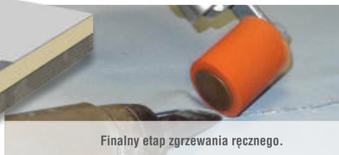
Zgrzewanie membrany na atyccie.
