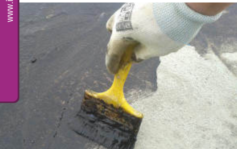
Gruntowanie powierzchni za pomocą IZOHAN DYSPERBIT.
