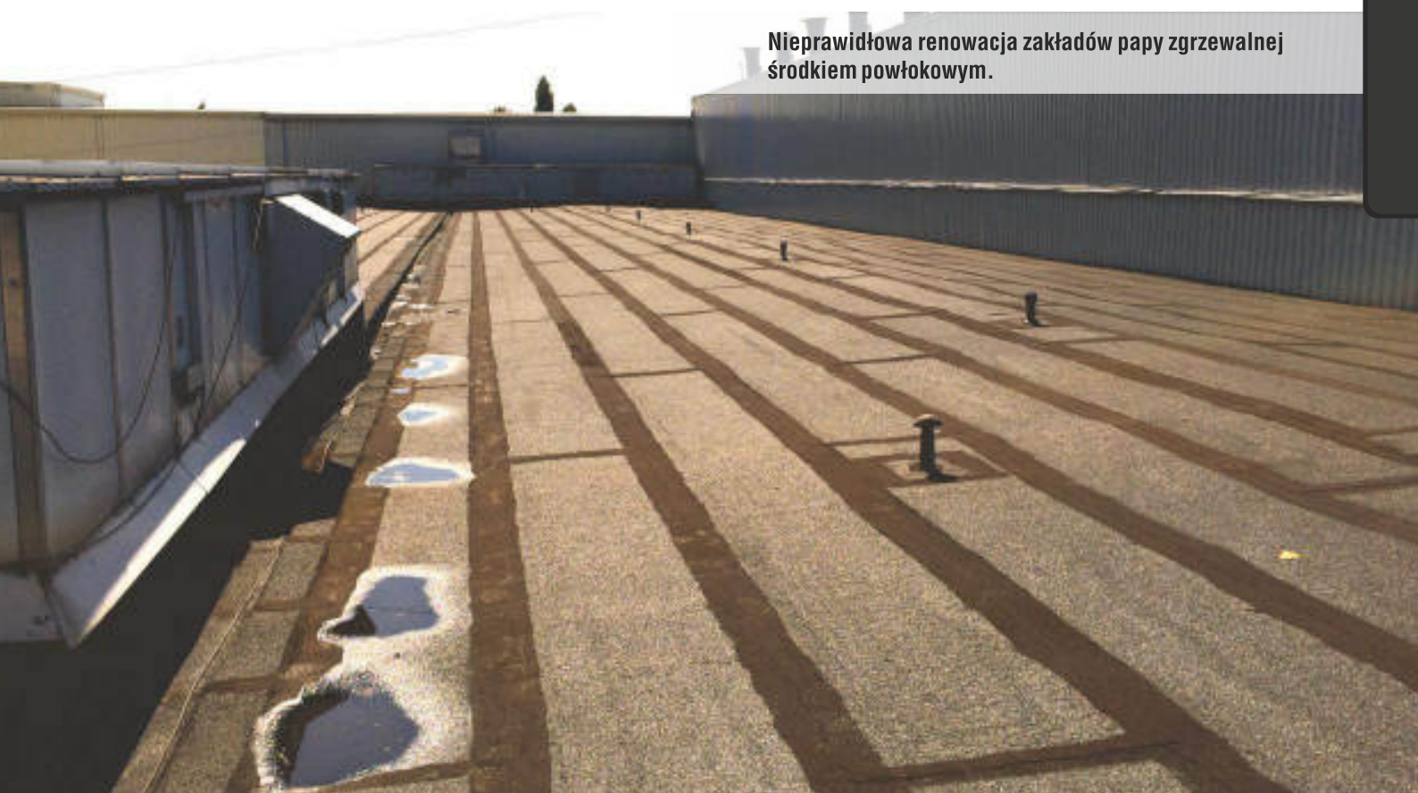
Nieprawidłowo wykonany zakład poprzeczny. Zakład nie został odpowiednio zgrzany i był zbyt wąski, brak wtopienia posypki na zakładzie na papie spodniej.
