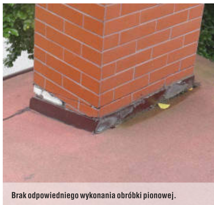
Popekana papa oksydowana na osnowie z welonu szklanego użyta do obróbki.
