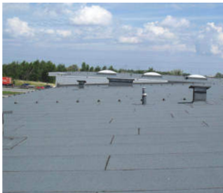
Dach płaski z prawidłowo zaplanowanymi i umocowanymi pasmami papy.
