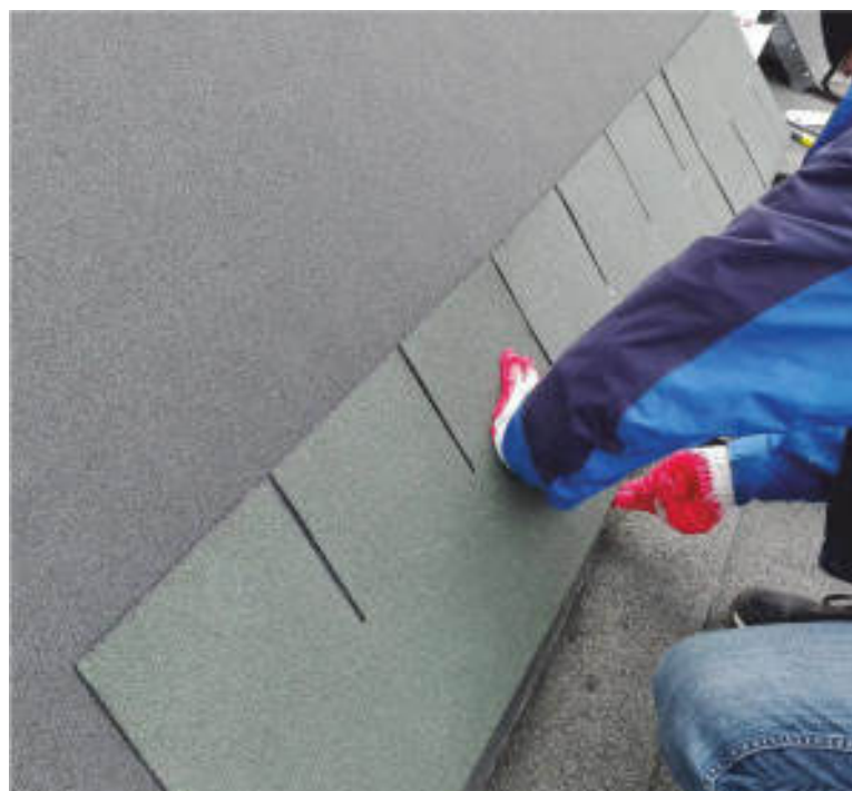
Pierwszą warstwę gontów należy układać odwrótnie, czyli modułami do góry.
