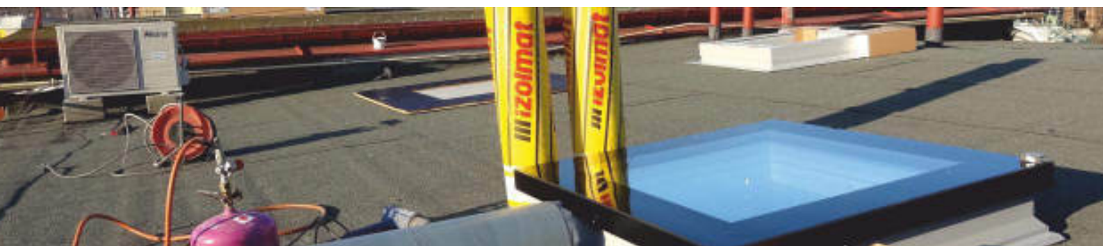
Zgrzewanie papy wokół podstawy świetlika.
