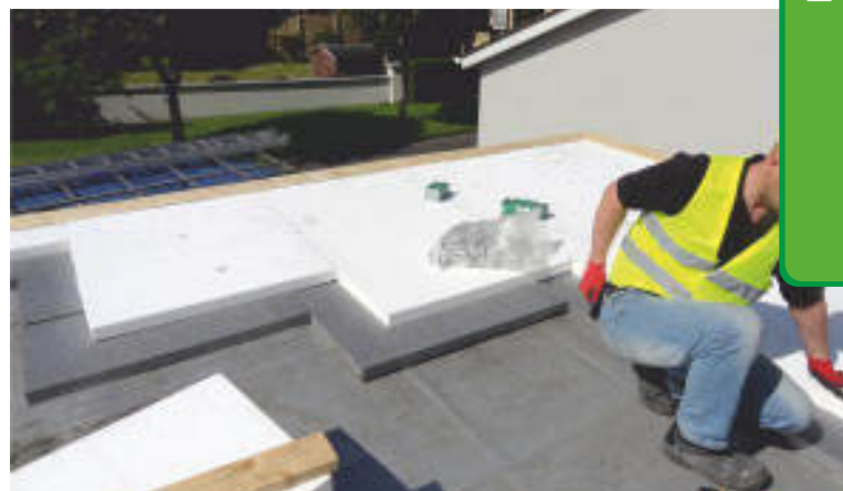
Układanie dwóch warstw płyt EPS.
