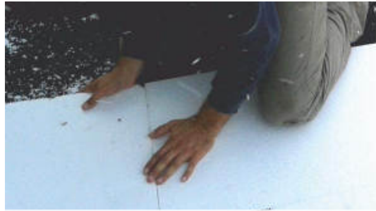
Układanie termoizolacji.
