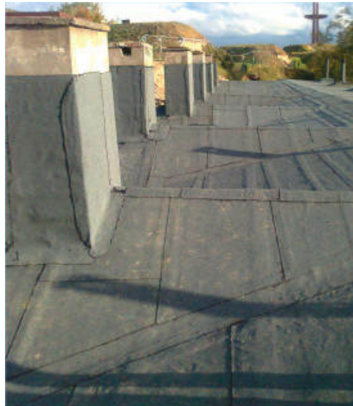
Pierwsza warstwa papy pod dach zielony o odwróconym układzie warstw.
