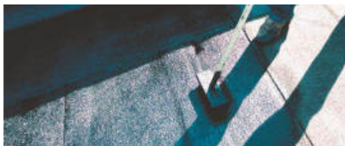
Stare pokrycie papowe, należy zagruntować przed przystąpieniem do dalszych prac renowacyjnych.
