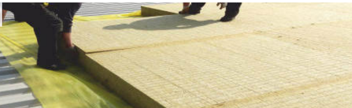
Mocowanie termoizolacji.
