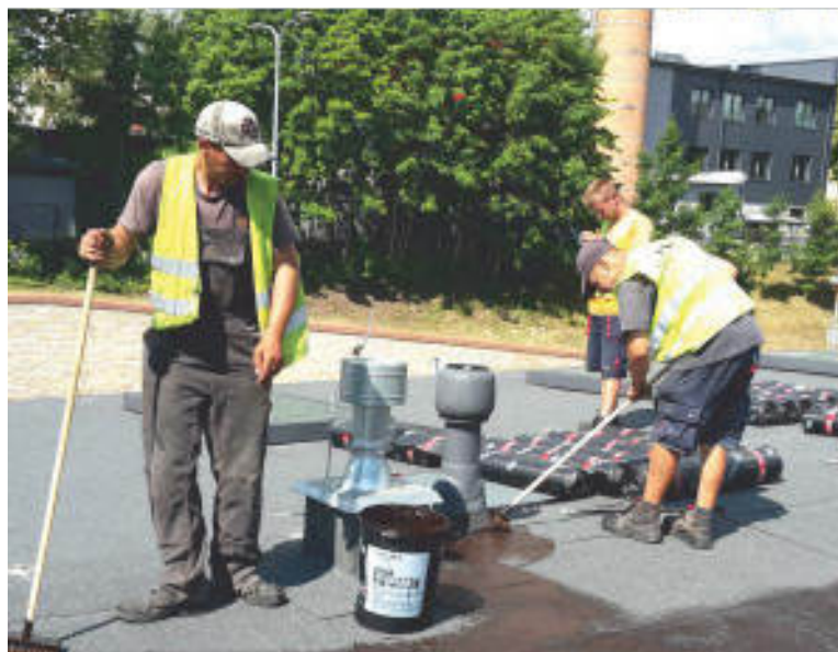
IZOHAN DYSPERBIT przed gruntowaniem chłonnego podłoża np. starego pokrycia papowego lub podłoża betonowego należy rozcieńczyć z wodą w stosunku 1:1.
