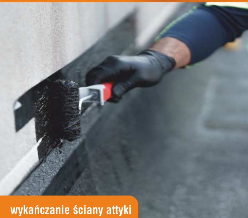
uszczelnianie przejść pion-poziom
