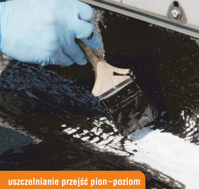
łączenie różnych podłoży
