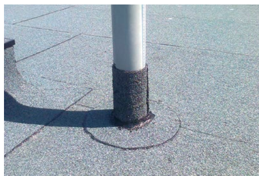
Obróbka elementu pionowego o kształcie okrągłym
