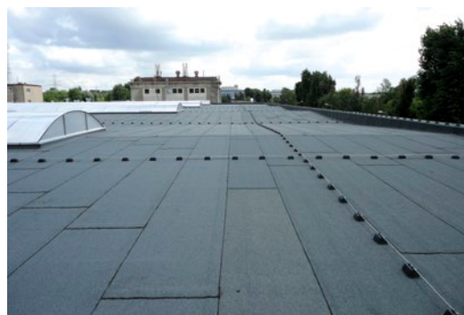
Prawidłowo zaplanowane ułożenie pasm papy
