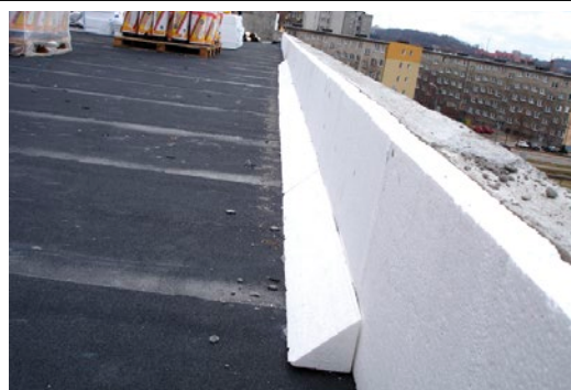
Styk powierzchni pionowej z poziomą
