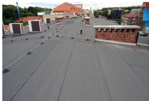
Wyremontowane pokrycie dachowe
