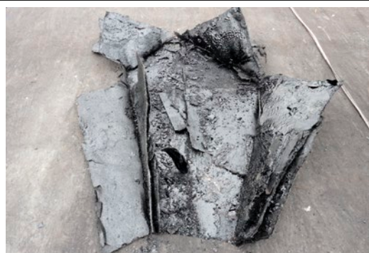
Suszenie podłoża pod pęcherzami z papy
