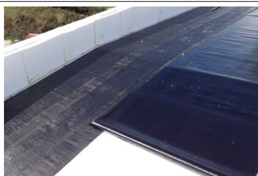
Zastosowanie papy samoprzylepnej
