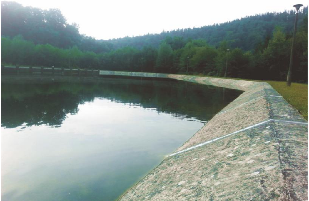
Stacja uzdatniania wody, Głuchołazy
